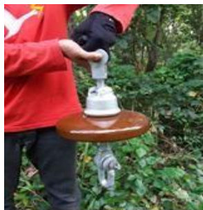
Gambar 3.3. Pemasangan Rangkaian Insulator Gantung
