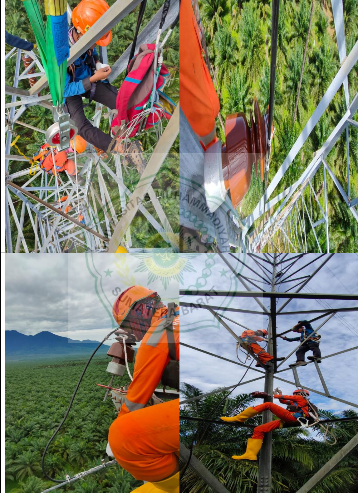
Lampiran 2: Pemasangan DGS
