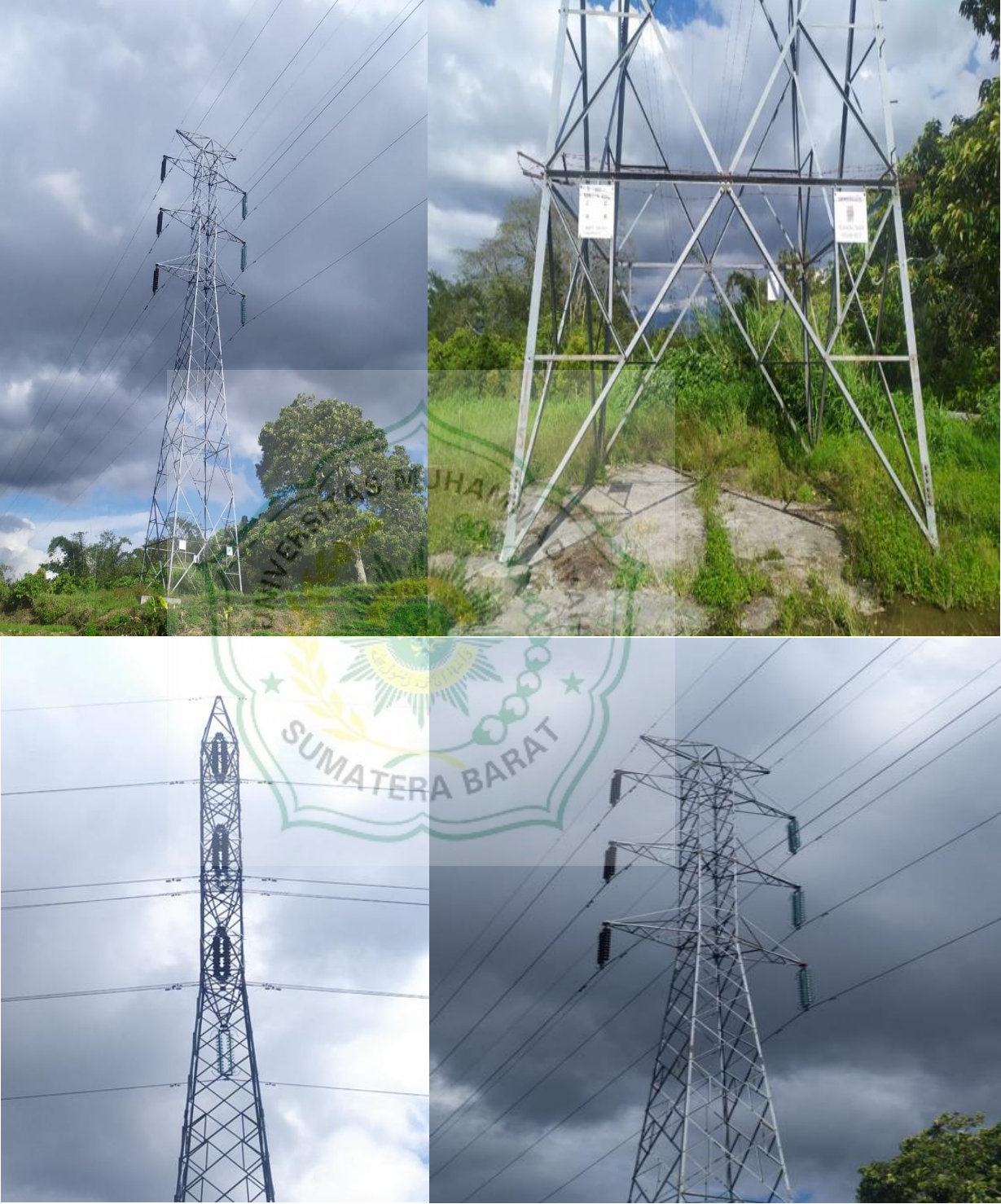
Lampiran 3: Konstruksi Tower 150 K
