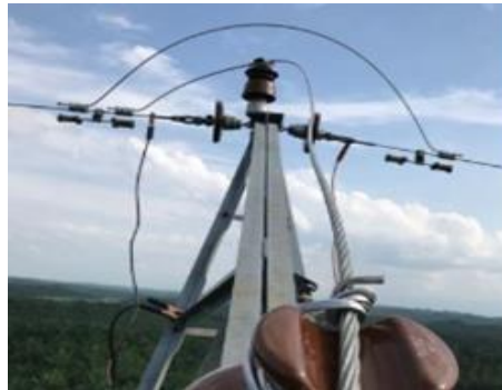
Gambar 3.4. Pemasangan Grounding Lokal
