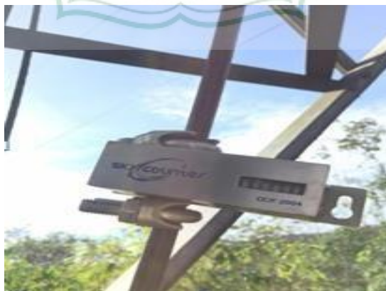
Gambar 3.11. Pemasangan Lightning Event Counter
