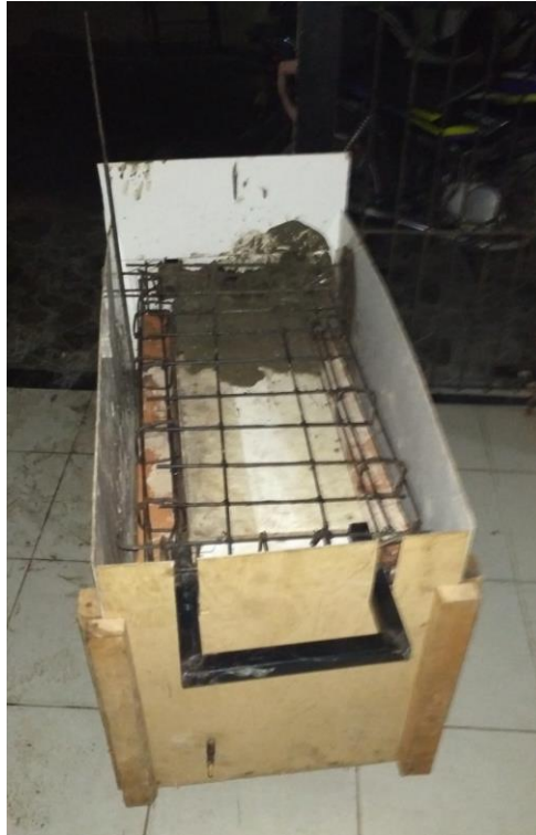
Gambar 5. Pemasangan bata dan rangka
