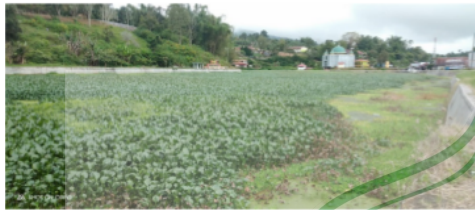
Gambar 1. Kondisi Embung yang ditumbuhi eceng gondok Jorong Kayu Tanduak, Nagari Aia Angek
