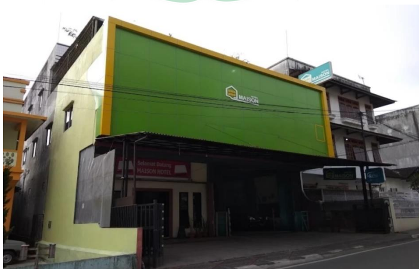
Gambar 2. Hotel Maison Bukittinggi
