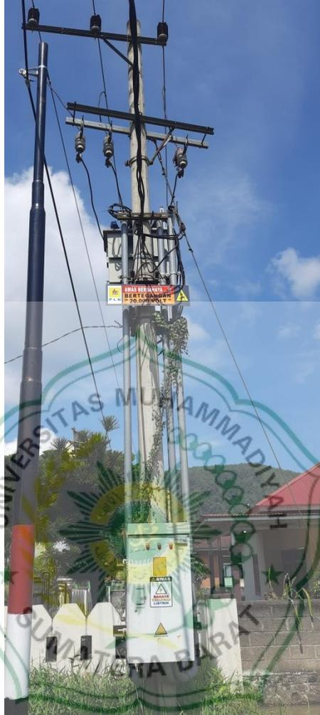
Gambar 2.8 Konstruksi Gardu Cantol
