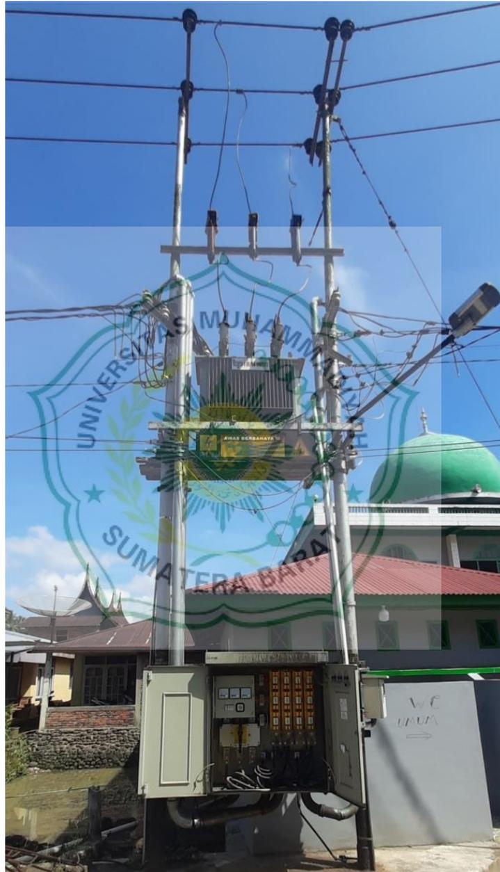
Gambar 2.7 Konstruksi Gardu Portal
