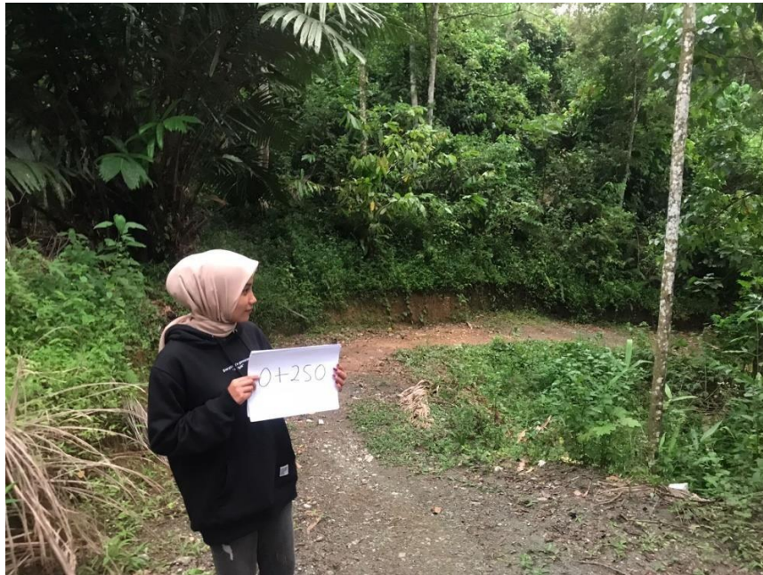
Gambar: Pengukuran Jalan STA 0+250 Sumber: Dokumentasi Lapangan (02-08-2023)
