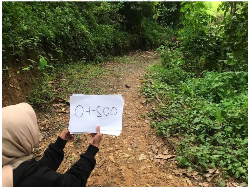
Gambar: Pengukuran Jalan STA 0+500 Sumber: Dokumentasi Lapangan (02-08-2023)
