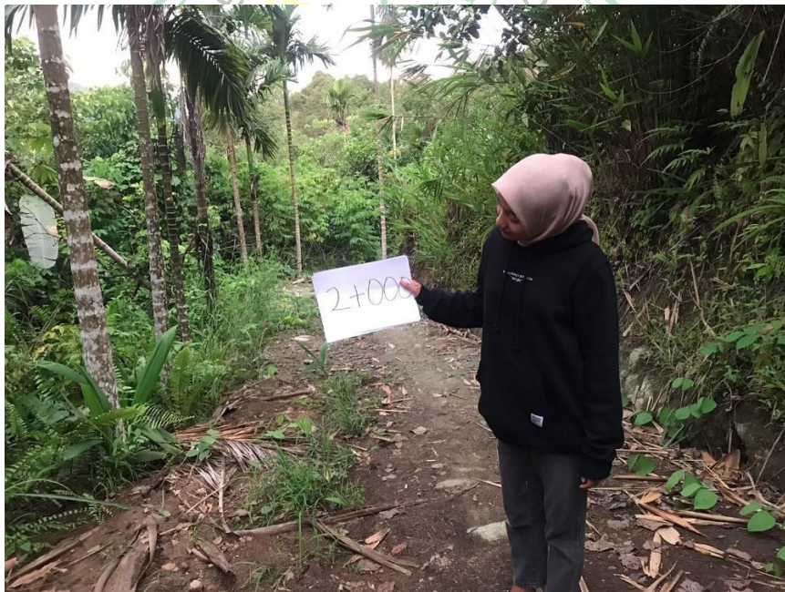
Gambar: Pengukuran STA 2+000 Sumber: Dokumentasi Lapangan (02-08-2023)
