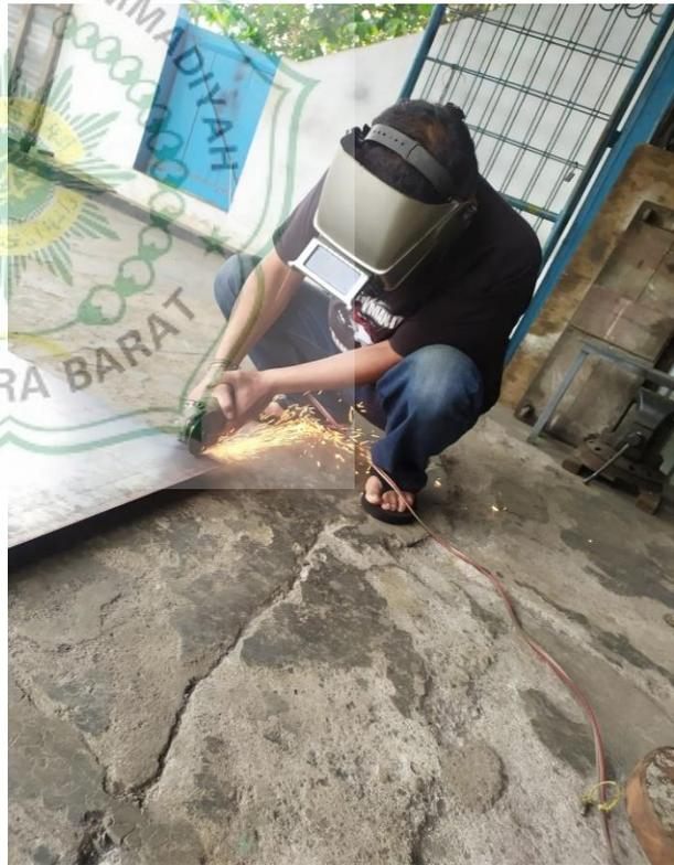
Pengukuran dan pemotongan baja lembaran untuk bak pengaduk
