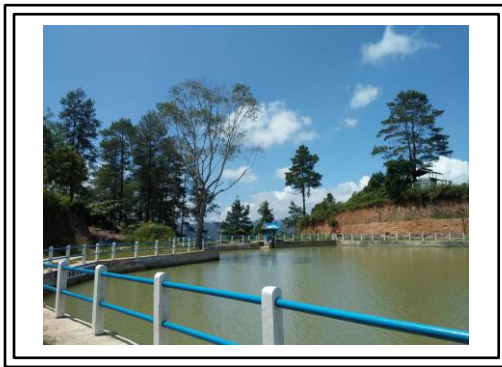
5. Pinggiran Embung yang Sudah Didam
