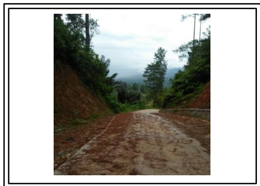
8. Jalan yang Sangat Curam
