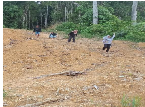
18) Jalan yang Sudah di Excavator
