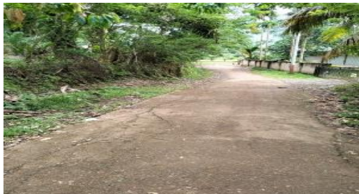
a) Jalan Cor
