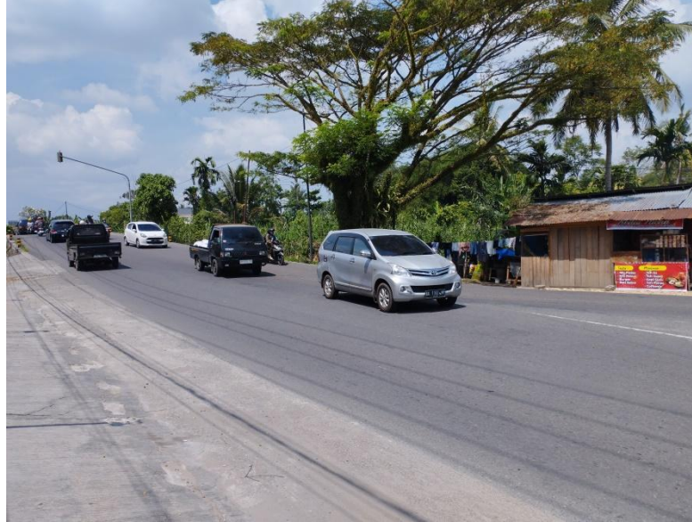
Gambar 3. 2 Kondisi Eksisting Simpang Bunga Setangkai Sumber : Survey Lapangan
