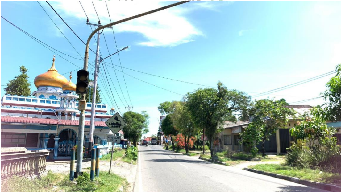
Lampiran 4 : Foto jalan menuju perlintasan sebidang yang tidak ada pita pengaduh
