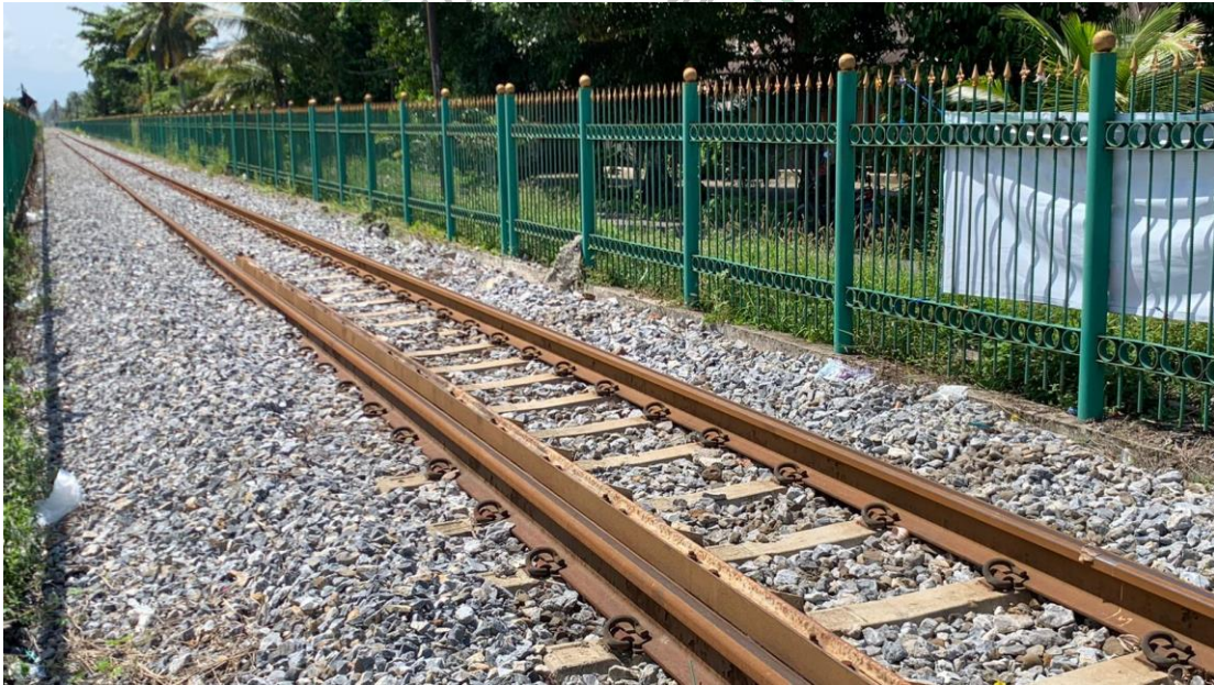
Lampiran 2 : Foto kondisi rel sudah terpasang pagar pembatas
