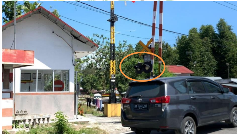
Gambar 4.4 : Tidak Aktifnya APILL Sumber : Lokasi Penelitian, 2023
