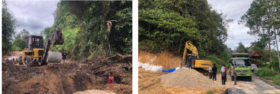
Foto Dokumentasi Alat pekerjaan Galian dan Timbunan
