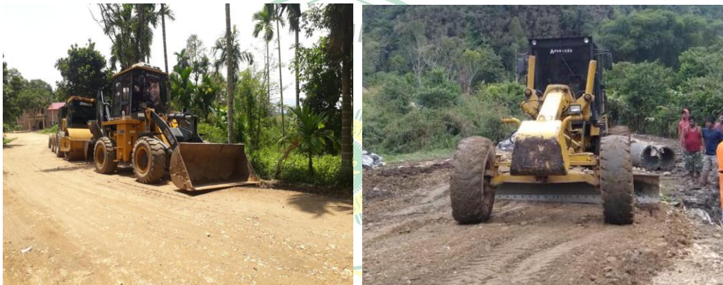
Foto Dokumentasi Alat pekerjaan Penyiapan Badan Jalan
