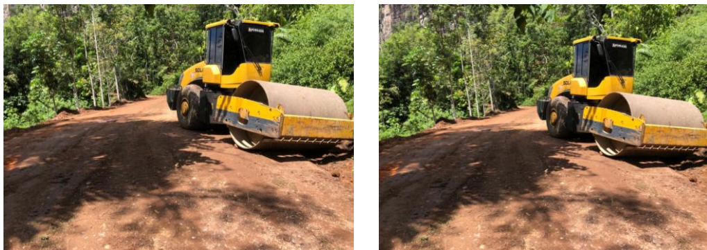
Foto Dokumentasi Alat pekerjaan Persiapan Penghamparan Klass A
