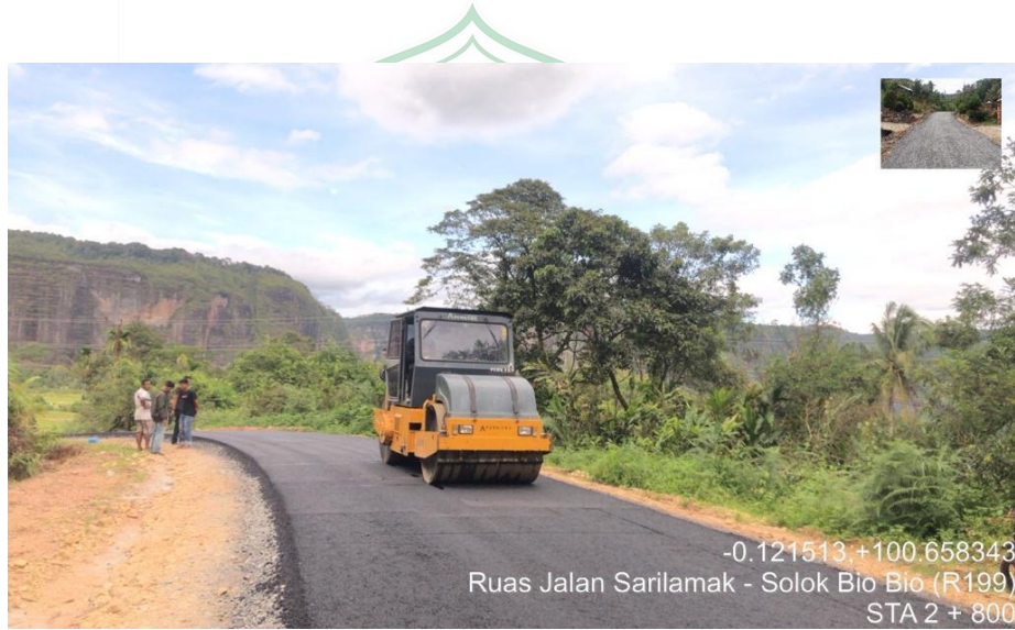
Foto Dokumentasi Pekerjaan 100 %
