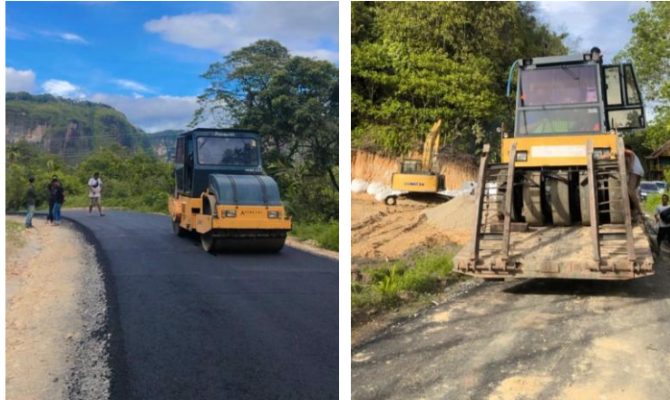
Foto Dokumentasi Alat pekerjaan Lapis Laston AC-BC
