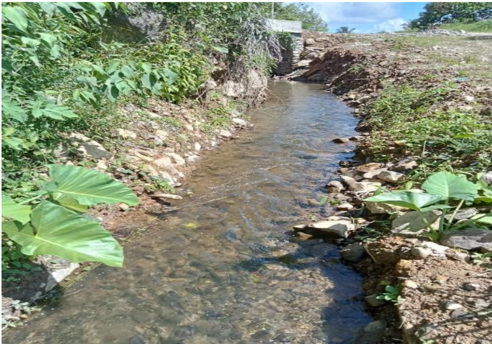
Dokumentasi : Saluran Irigasi Batang Sopan
