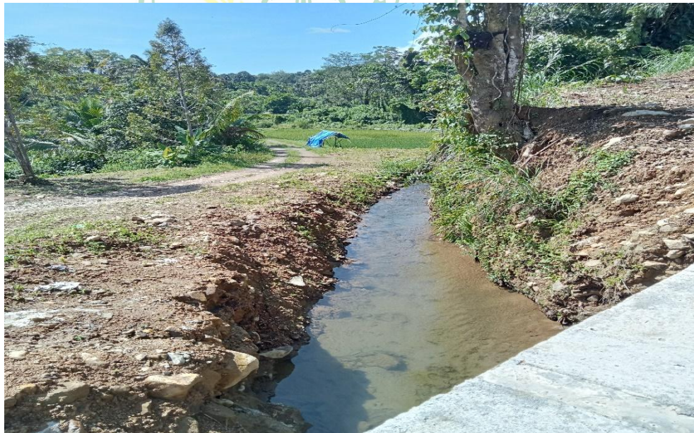
Dokumentasi : Saluran irigasi Batang Sopan
