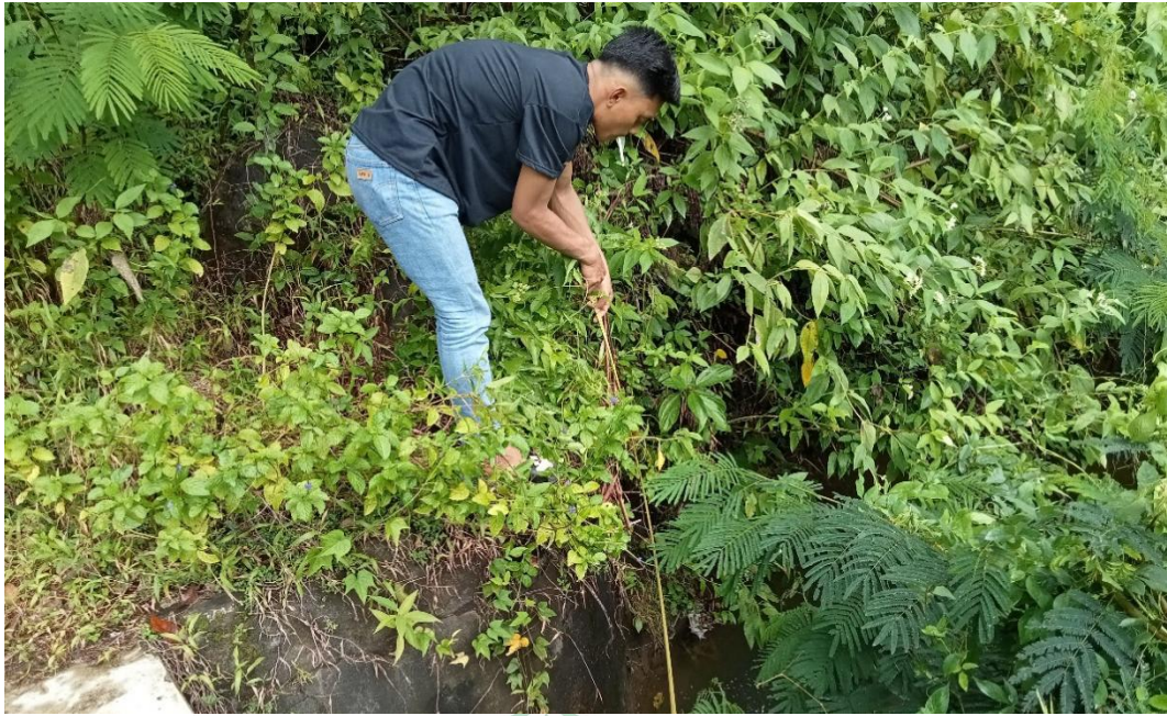
Dokumentasi : Pengukuran Saluran irigasi
