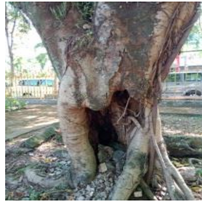
Serangan Rayap Pada Pohon Disekitar Bangunan
