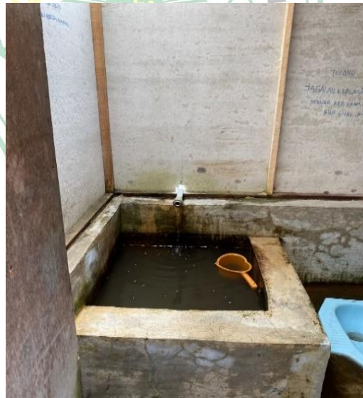
Gambar : 4.5 Toilet umum yang sudah dibersihkan
