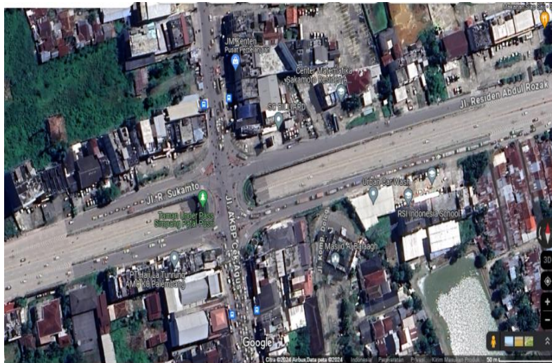
Gambar 1. Tampak atas lokasi Underpass Patal-Pusri
