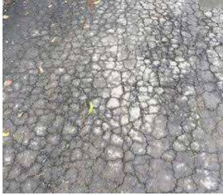
Gambar 2.4 Retak Kulit Buaya
