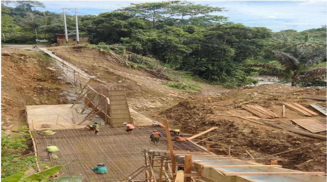
Foto pekerja sedang melakukan pekerjaan
