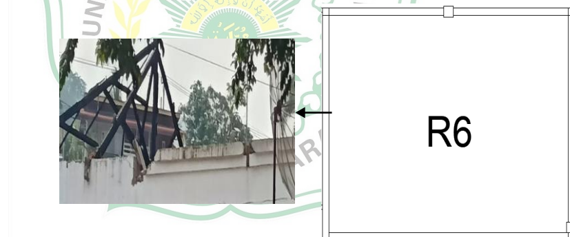
Gambar 4.11 Denah dan kerusakan struktur balok pada ruang R6 Sumber : Dokumentasi lapangan
