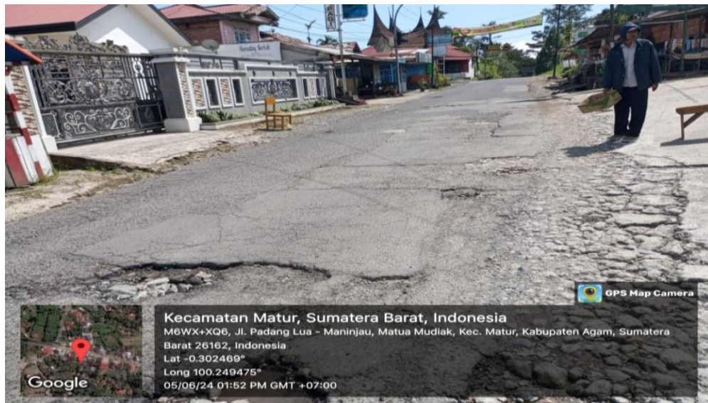
Gambar 4.2. Ruas jalan matuak mudiak Sumber : Dokumentasi survei (2024)
