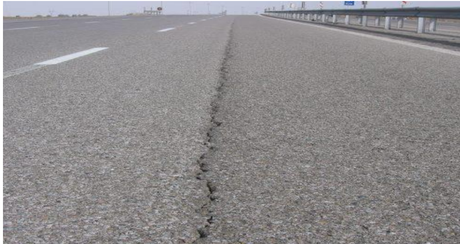
Gambar 2.1. Retak memanjang Sumber : Hardiyatmo,H.C. (2007)
