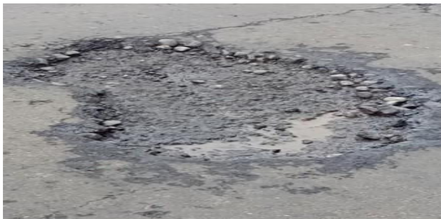
Gambar 2.10. Pelepasan butiran Sumber : Hardiyatmo,H.C. (2007)
