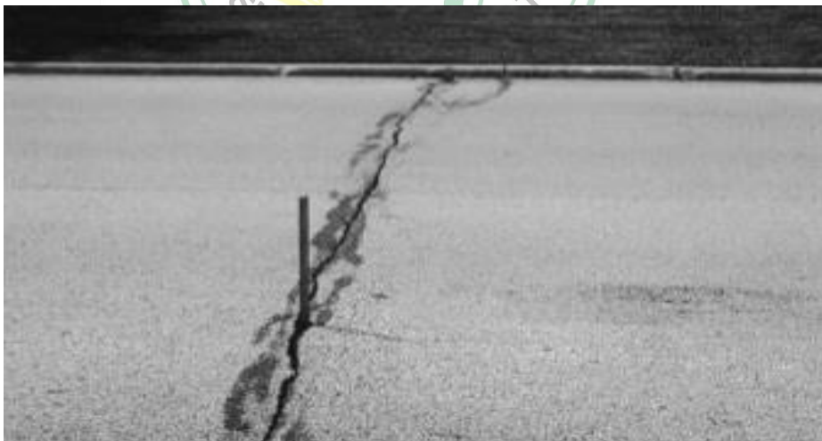
Gambar 2.2. Retak melintang Sumber : Hardiyatmo,H.C. (2007)
