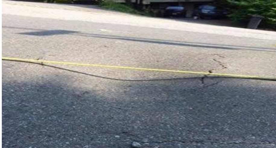
Gambar 2.8. Kerusakan amblas Sumber : Hardiyatmo, H.C. (2007)
