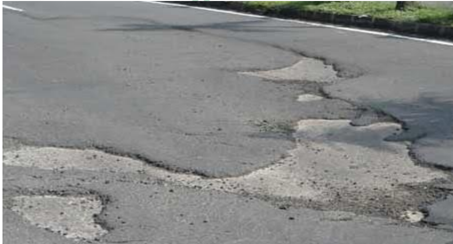
Gambar 2.11. Pengelupasan lapisan permukaan Sumber : Hardiyatmo,H.C. (2007)
