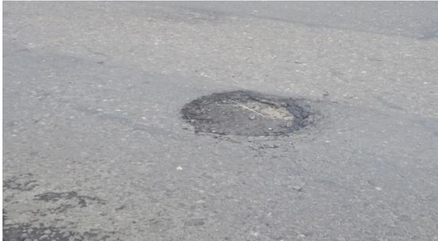
Gambar 2.9. Lubang Sumber : Hardiyatmo,H.C. (2007)
