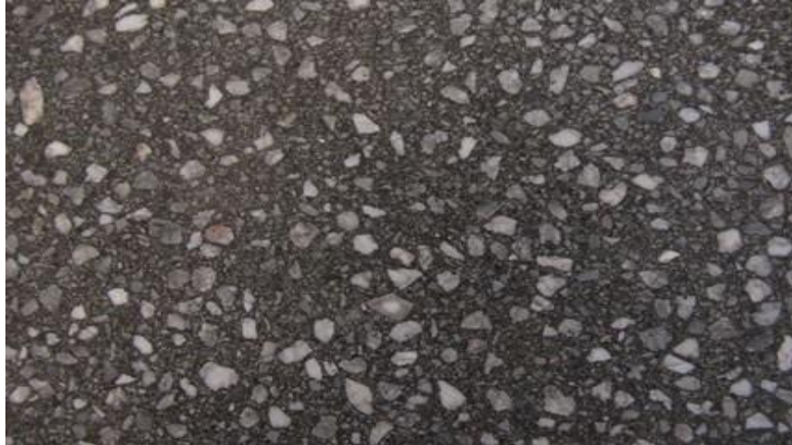
Gambar 2.12. Pengausan Sumber : Hardiyatmo,H.C. (2007)
