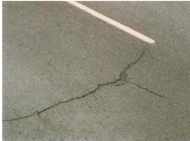
Gambar 2.13 Retak Bersambung
