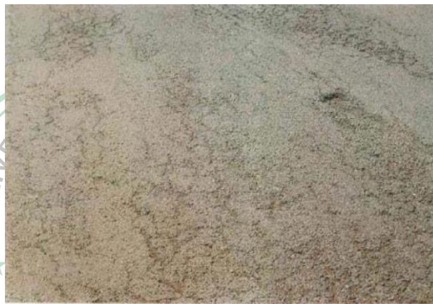
Gambar 2.1 Retak Kulit Buaya
