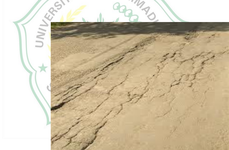
Gambar 2.10 Retak Memanjang
