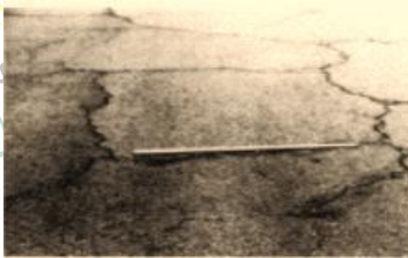
Gambar 2.3 Retak Blok
