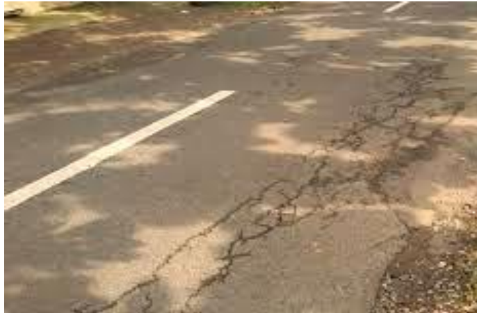
Gambar 2.4 Retak Pinggir
