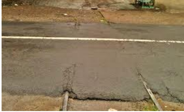
Gambar 2.11 Persilangan jalan rel
