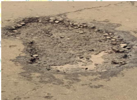
Gambar 2.12 Pelapisan Butir
