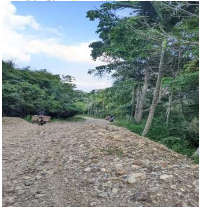
Gambar 3. 3 Kondisi jalan Kampung Baru Sumber : Dokumentasi lapangan (2024)
