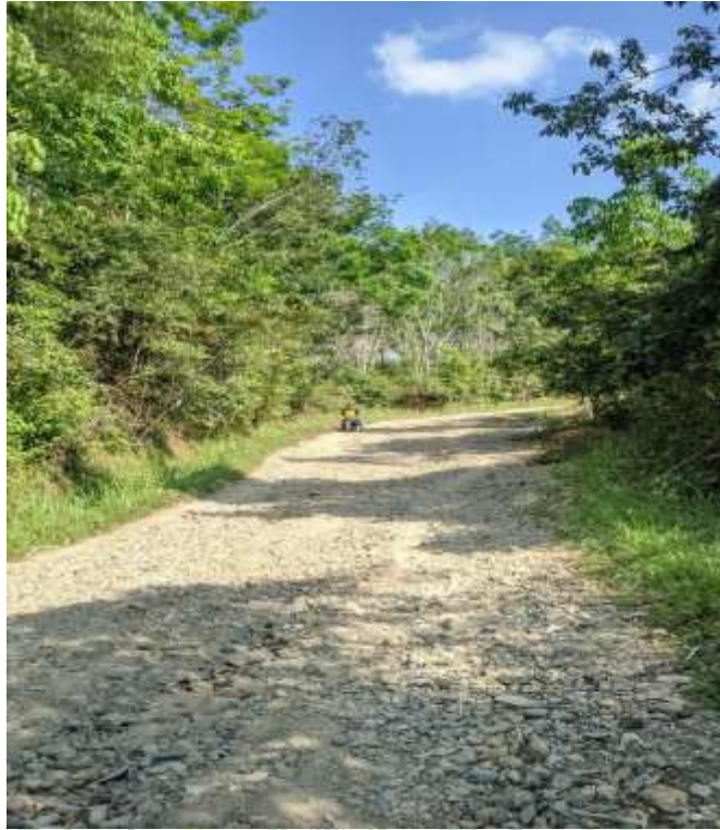
Gambar 3. 4 Kondisi jalan Kampung Baru Sumber : Dokumentasi lapangan (2024)
