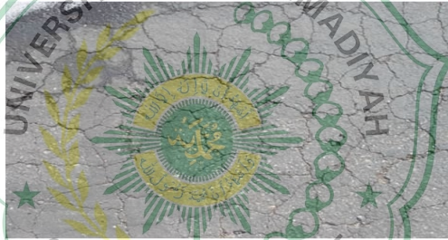
Gambar 2.8 Retak Susut
