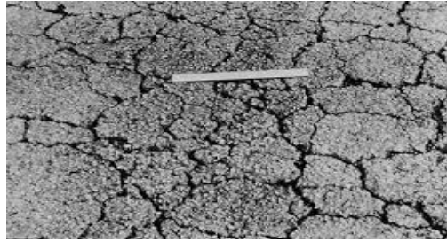
Gambar 2.2 Retak Kulit Buaya
