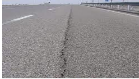
Gambar 2.1 Retak Memanjang
