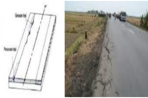
Gambar 2.3 Retak Pinggir
