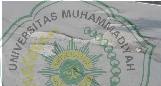
Gambar 2.17 Pengelupasan Lapis Permukaan
