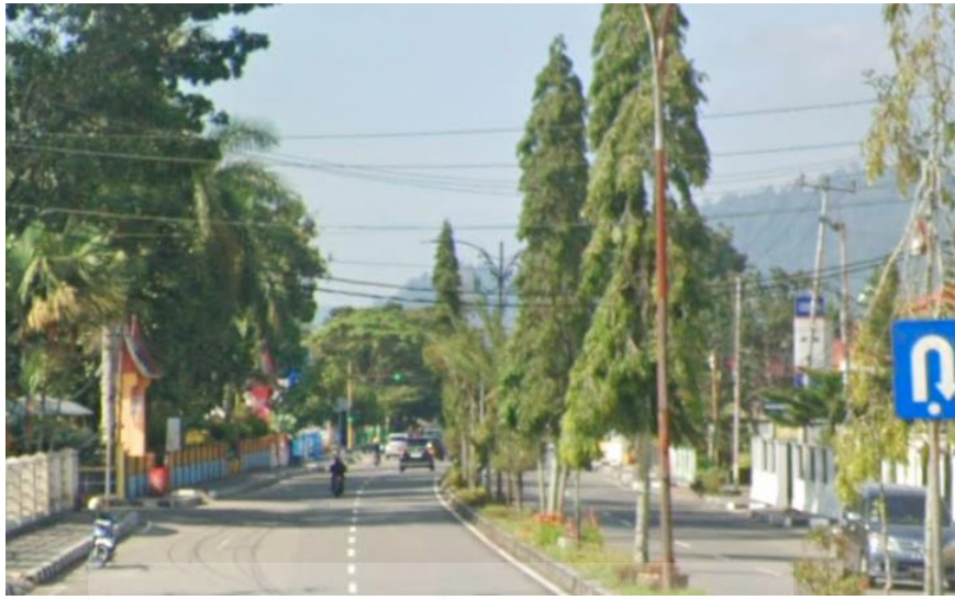
Jalan Jenderal Sudirman STA 0 + 000
