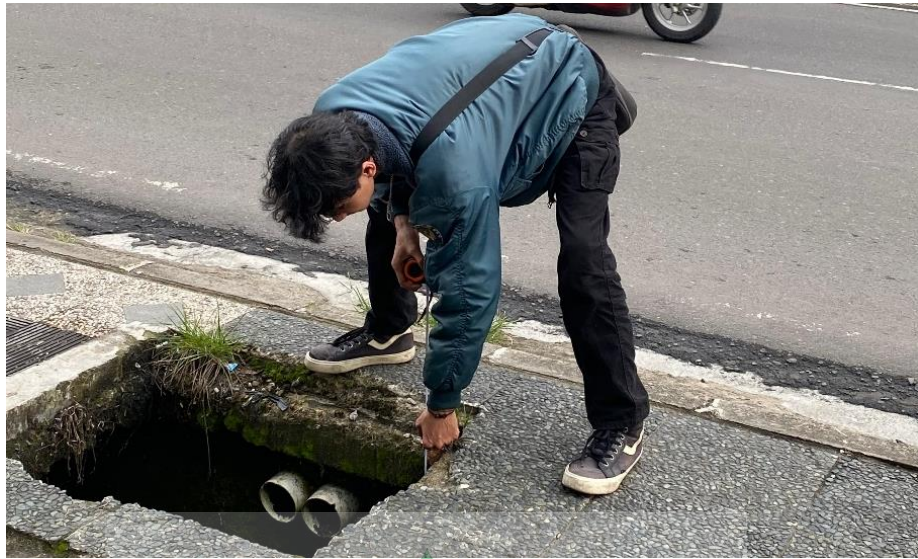
Pengukuran Saluran Drainase Eksisting
