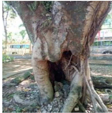
Serangan Rayap Pada Pohon Disekitar Bangunan
