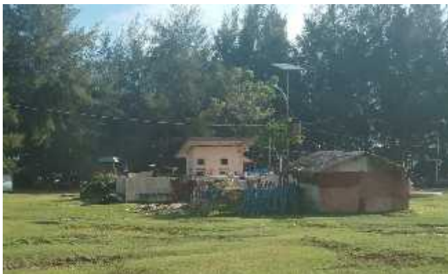
Gambar 1.5 Salah satu bangunan tempat mandi, cuci dan kakus (mck)
