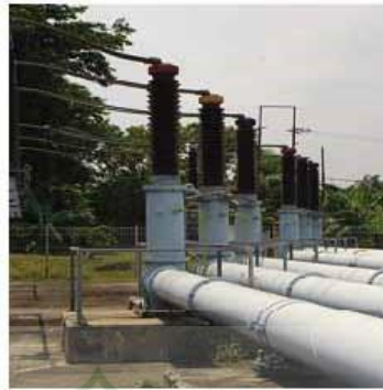
gambar 6 :Saluran Listrik Isolasi Gas
