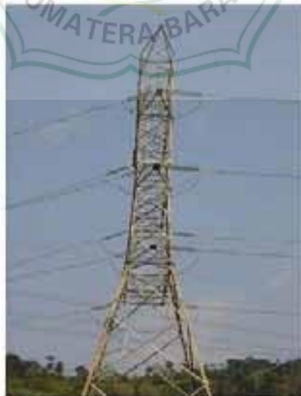
gambar 9 : Tiang Saluran Jenis Lattice
