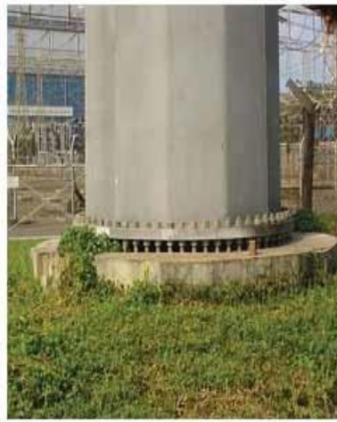
gambar 13 : Pondasi Steel 500kV Dead end
