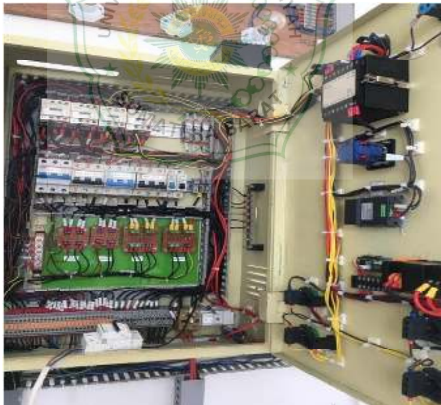
Gambar 4.7 Panel Kontrol Sistem Pembangkit Listrik Hybrid Tenaga Surya dan PLN
