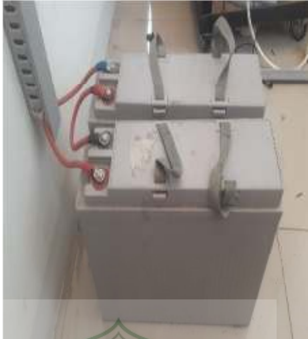
Gambar: 2.3 Baterai 12 V DC 100 Ah 2 buah
