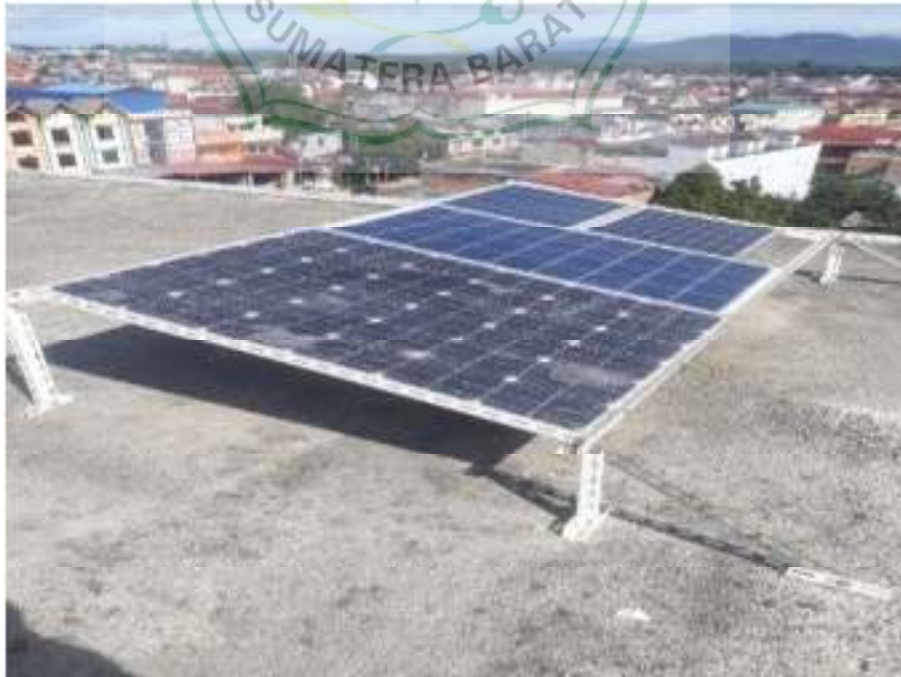
Gambar 4.5 Panel Surya 100 WP 2 buah dihubungkan seri
