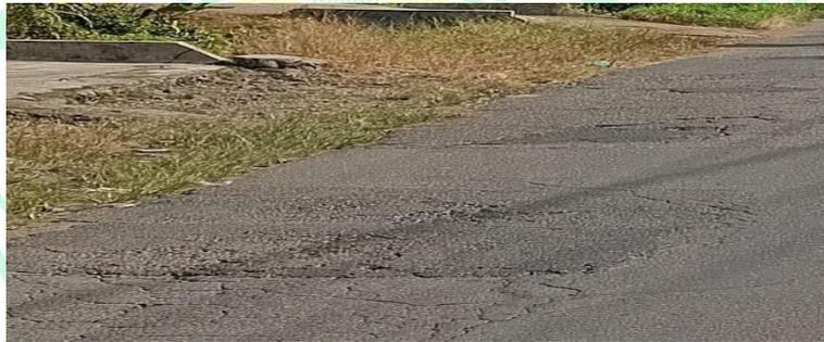
**Gambar 3.2** Jalan yang retak dan bergelombang
