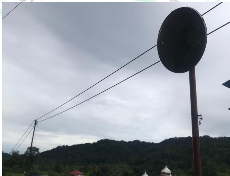
Gambar 4.1 Kondisi rambu yang sudah tidak berfungsi
