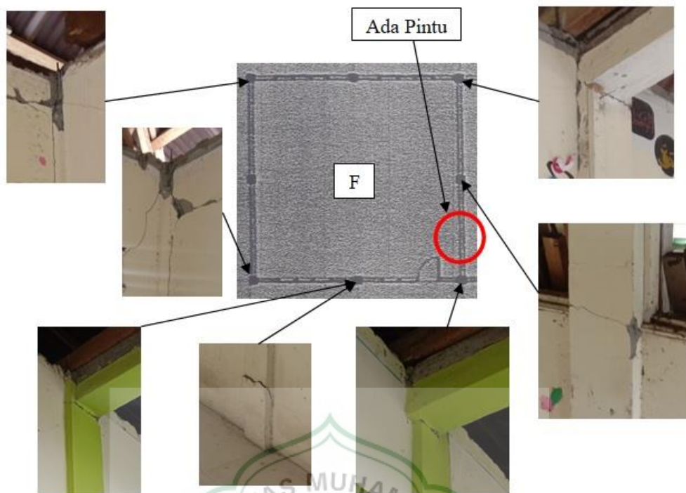
Gambar 4.14. Denah dan kerusakan struktur pada ruangan F
