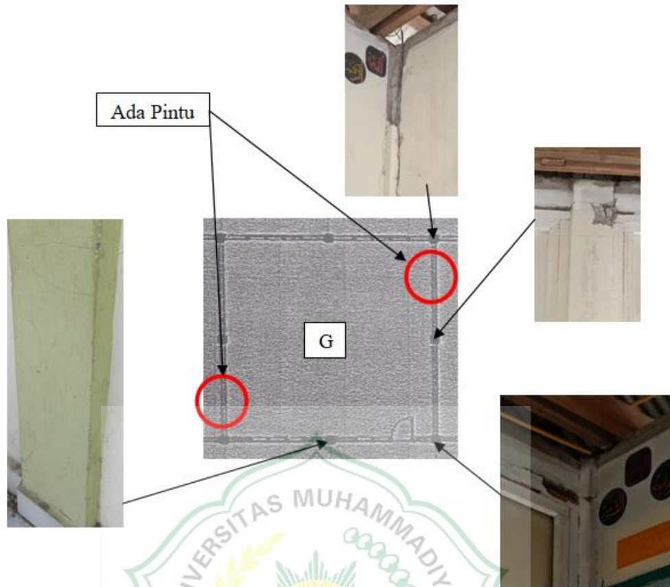
Gambar 4.16. Denah dan kerusakan struktur pada ruangan G
