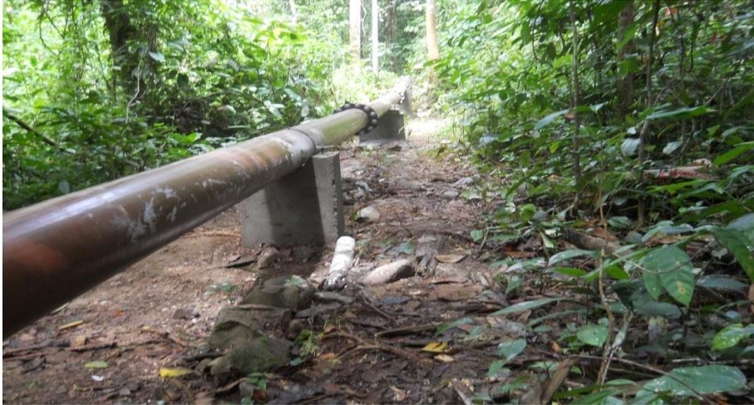
Gambar 2.2: Jaringan Pipa Transmisi Pipa Gi Ø 250 mm
