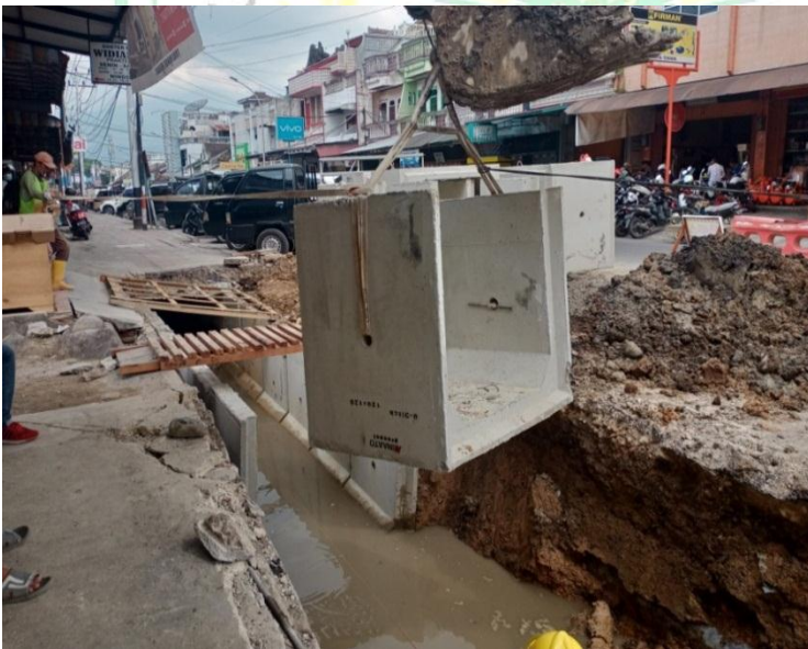
Gambar 4 . Drainase Tipe U- Ditch Jalan A. Yani Kota Payakumbuh Sumber: Dokumentasi Penelitian, 2019
