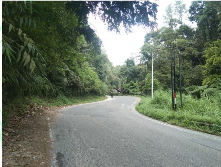
Gambar 4.1. Kondisi Jalan Raya Bukittinggi-Medan KM 8. Sumber : Dokumentasi (2022)
