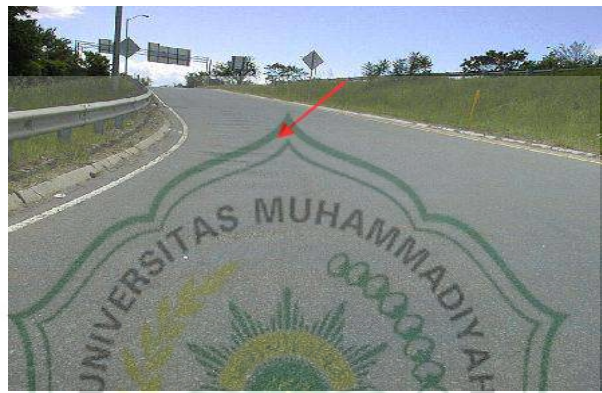
Gambar 2.7 Kerusakan Jalan Keriting ( Corrugation )
