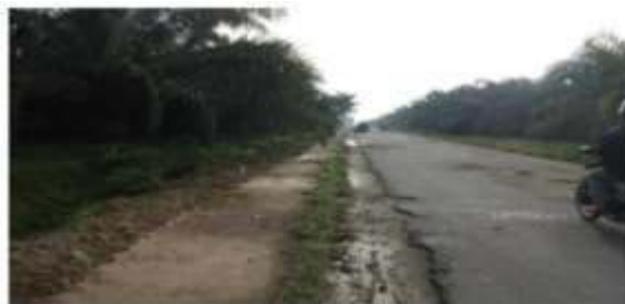
Gambar 2.5 Retak Pinggir
