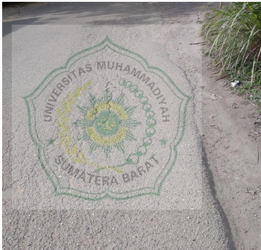
Gambar 4.3 Retak Kulit Buaya
