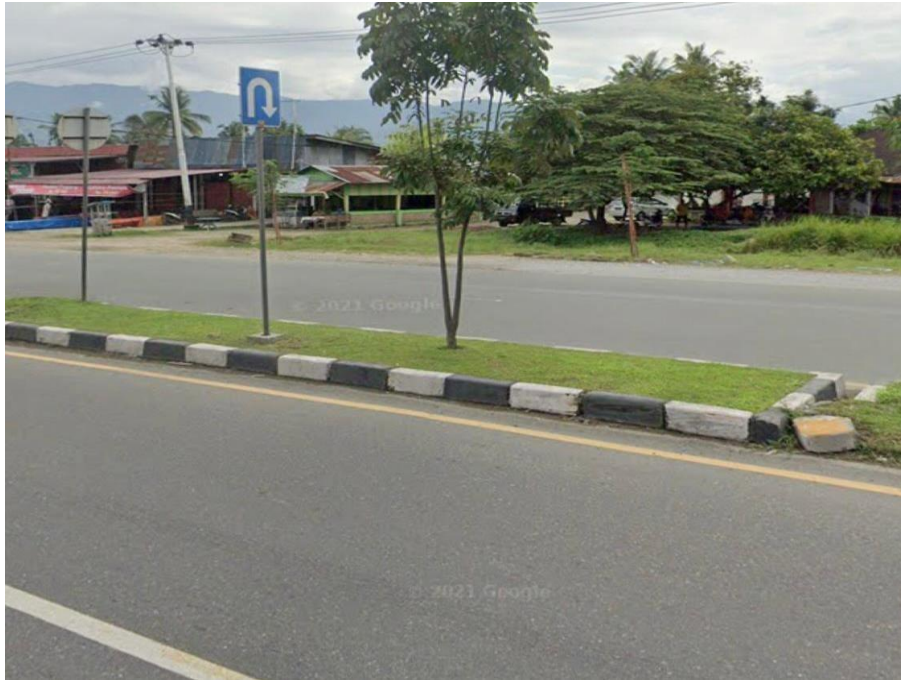
Gambar 4. 2 Kurangnya rambu jalan
