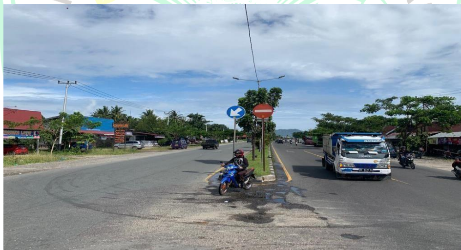
Gambar 4. 1 Keadaan jalan Bypass Kota Padang KM 10
