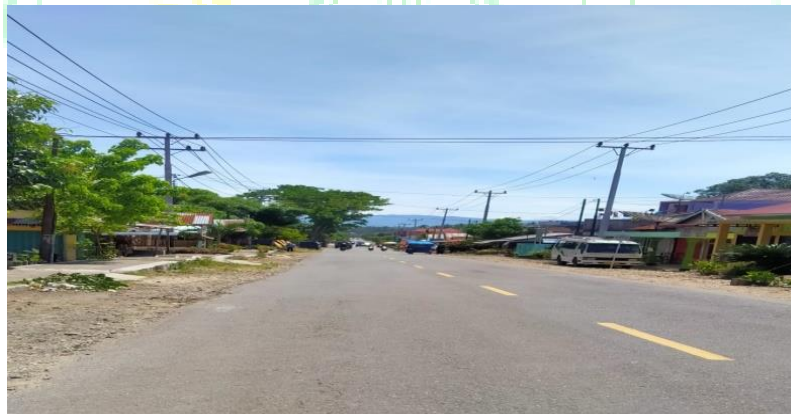
Gambar 4.1. Keadaan jalan lintas Sumatera, Cengkeh KM 35, Kecamatan Panti, Kabupaten Pasaman.
