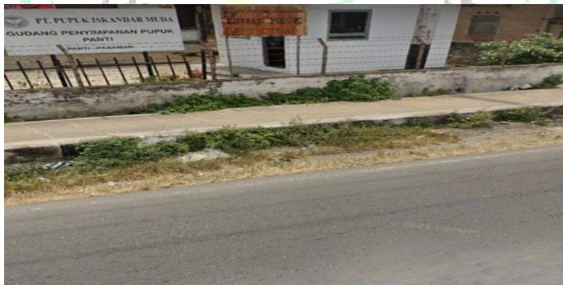
Gambar 3.4. Keadaan bahu jalan.
