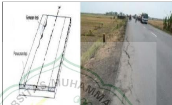
Gambar 2.7 Retak Pinggir Sumber: Google (2021)
