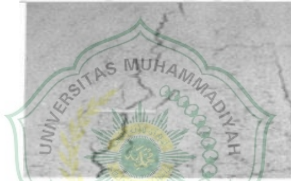
Gambar 2.10 Retak Memanjang / Melintang Sumber : Google (2021)
