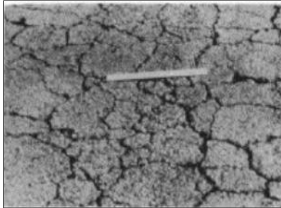
Gambar 2.1 Retak Kulit Buaya Sumber : Google (2021)
