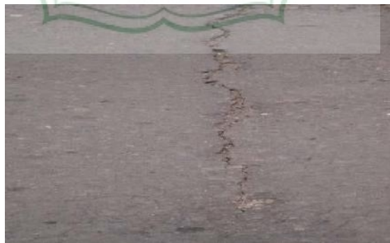
Gambar 2.9 Pinggiran Jalan Turun Vertikal
