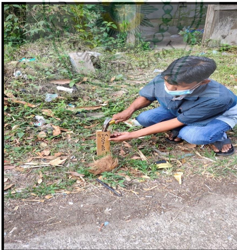
Foto 10. Pemasangan Plang STA. 00+600 Dokumentasi : Syamsuwirman, 20 Juli 2021, Jalan Raya Kubu Karambia-Pasar Pitalah
