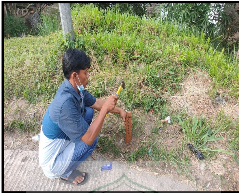
Foto 9. Pemasangan Plang STA. 00+200 Dokumentasi : Syamsuwirman, 20 Juli 2021, Jalan Raya Kubu Karambia-Pasar Pitalah
