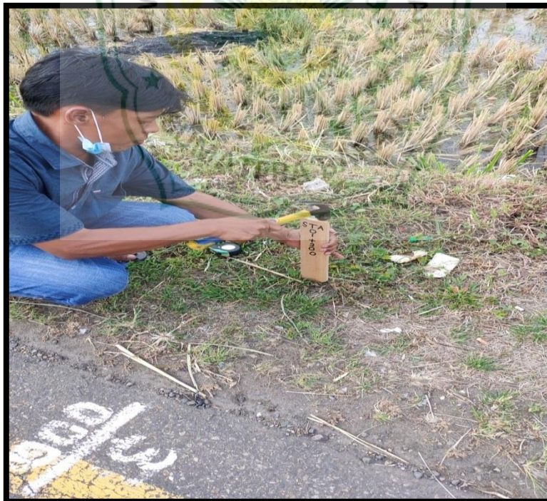
Foto 12. Pemasangan Plang STA. 01+200 Dokumentasi : Syamsuwirman, 20 Juli 2021, Jalan Raya Kubu Karambia-Pasar Pitalah
