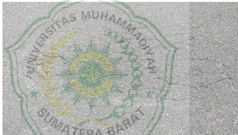
Gambar 4.3 Retak Kulit Buaya
