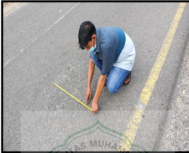
Foto 5. Pengukuran Kerusakanan Jalan Retak Kulit Buaya Dokumentasi : Syamsuwirman, 20 Juli 2021, Jalan Raya Kubu Karambia-Pasar Pitalah
