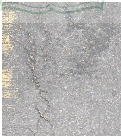
Gambar 4.1 Retak Memanjang
