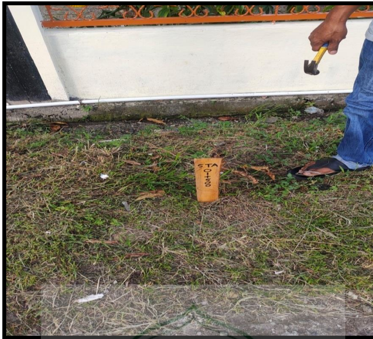
Foto 11. Pemasangan Plang STA. 01+500 Dokumentasi : Syamsuwirman, 20 Juli 2021, Jalan Raya Kubu Karambia-Pasar Pitalah
