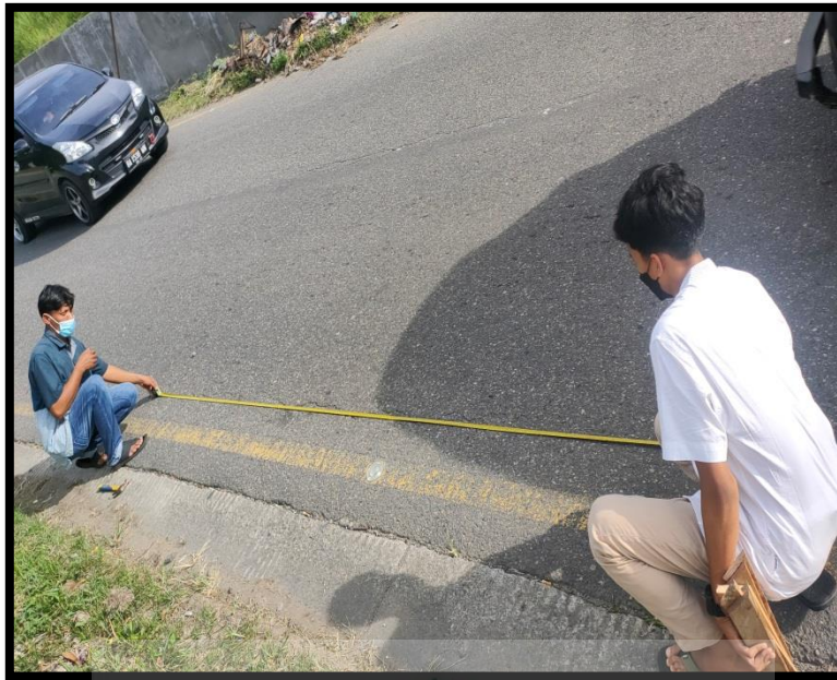
Foto 3. Pengukuran Kerusakanan Jalan bersama Andry Vernandes Dokumentasi : Syamsuwirman, 20 Juli 2021, Jalan Raya Kubu Karambia-Pasar Pitalah)
